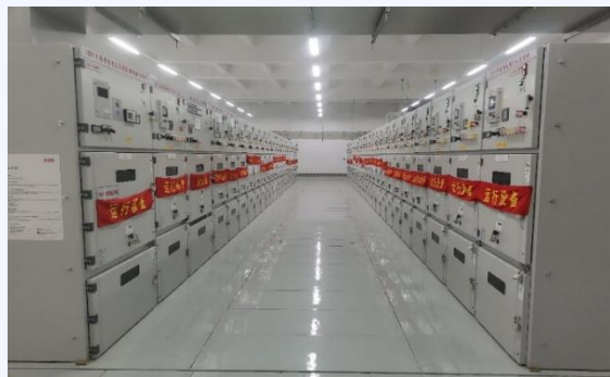
110kV变电站建成，容量80kVA
