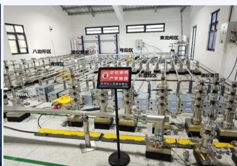
已完成注入器真空室现场安装
