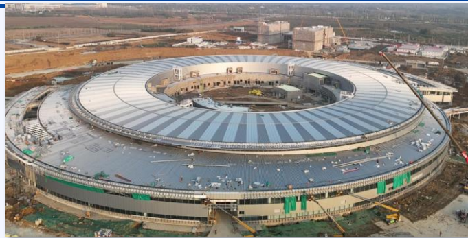
主体建筑-金属屋面
