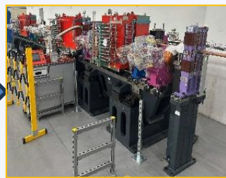
真空安装完成
