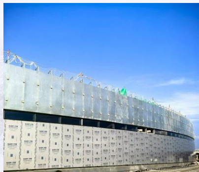
主体建筑-幕墙
