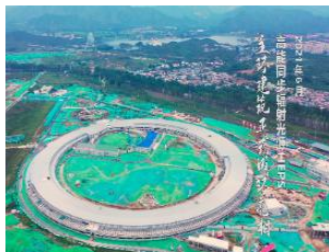
2021年6月27日 主环建筑单体封顶
