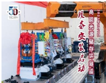
2023年2月1日 储存环隧道设备安装启动
