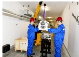
2021年6月28日 首台科研设备开始安装
