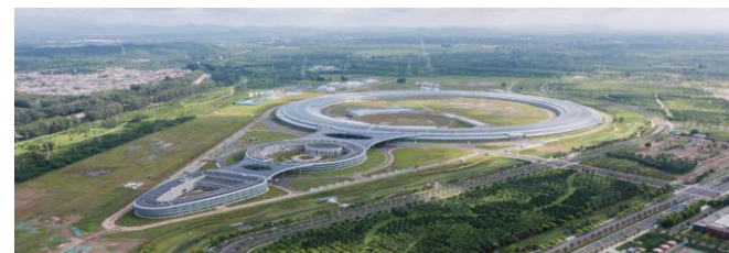
2023年11月3日 配套楼建筑通过五方验收
