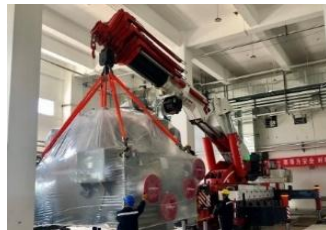
2021年4月13日 通用设施集成安装启动
