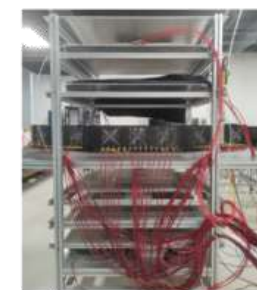
搭建测试平台
